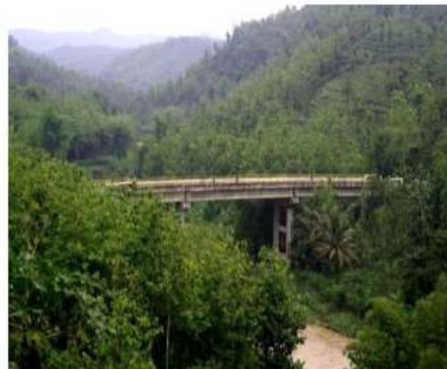
Jembatan melewati sungai sekaligus berfungsi sebagai koridor satwa
